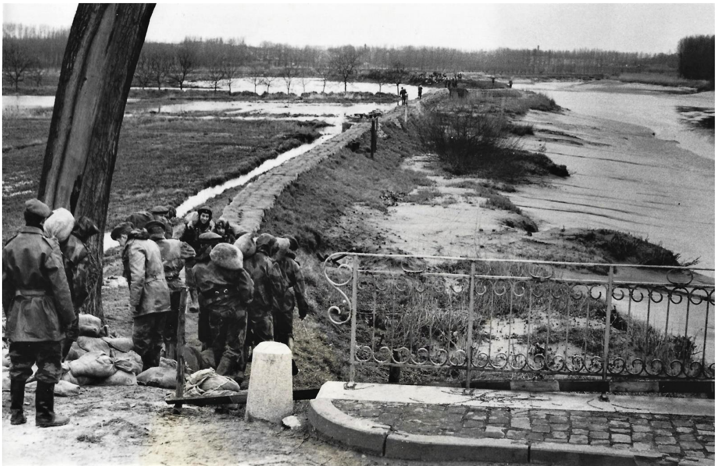
Herstelling dijkbreuk ter hoogte van de Durmebrug, kant Elversele | Fotoarchief Heemkring Osschaert.
